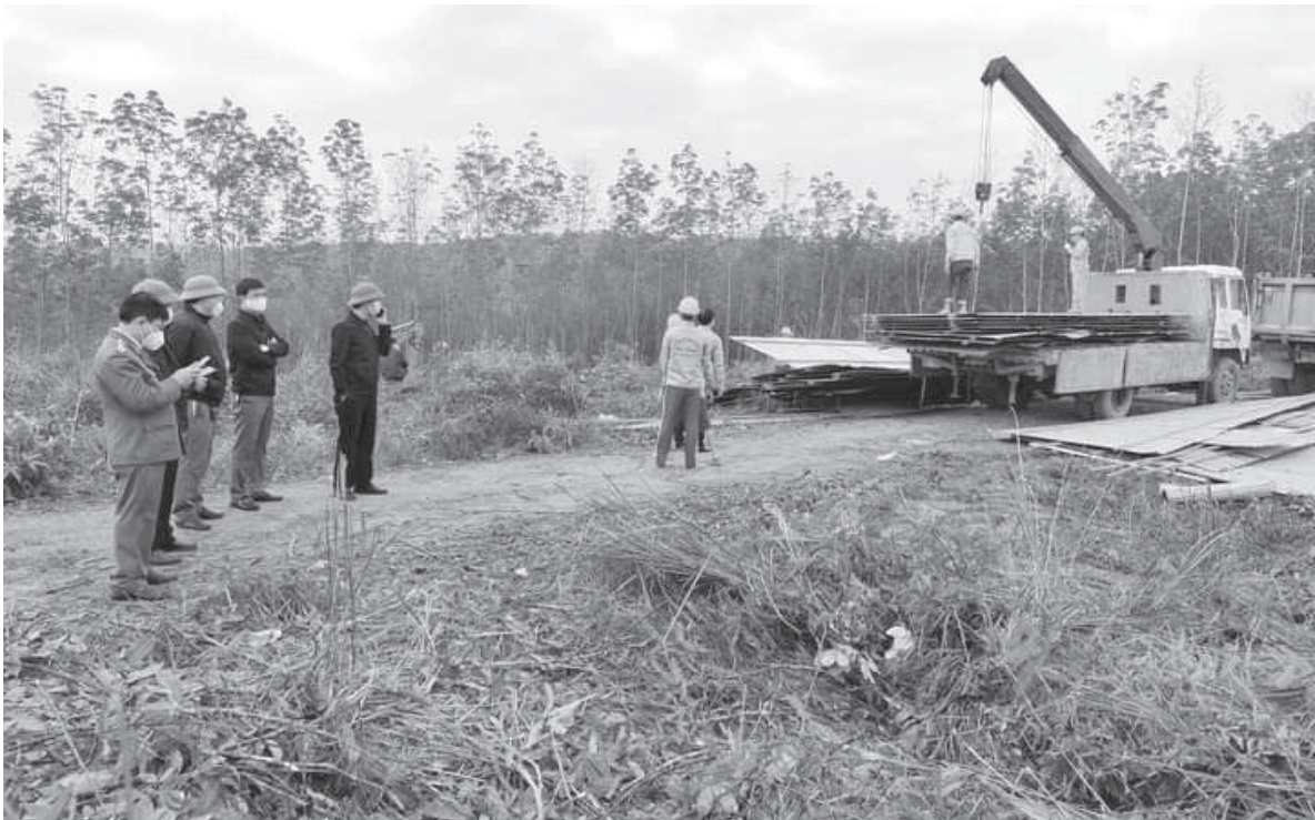
Lãnh đạo huyện Hương Khê trực tiếp chỉ đạo khởi công dự án xây dựng khu xử lý chất thải rắn tại khoảnh 6, tiểu khu 208, xã Hương Thủy
