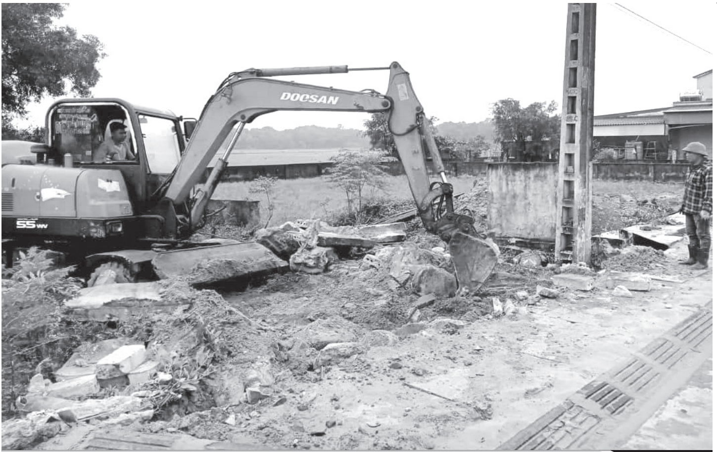
Anh Nguyễn Đình Sao bên tuyến hàng rào xây đang phá dỡ để mở rộng đường.
