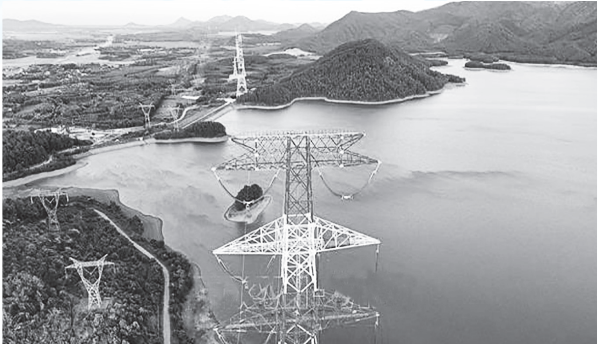
Đường dây 500kV mạch 3 được khánh thành sau hơn 6 tháng triển khai. Ảnh: TTXVN
