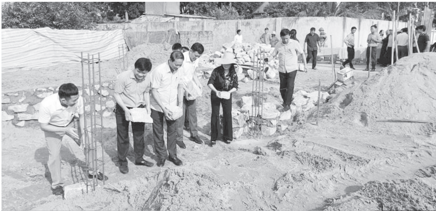
Khởi công xây dựng nhà ở cho hộ nghèo trên địa bàn xã Lộc Hà. Ảnh: PV
