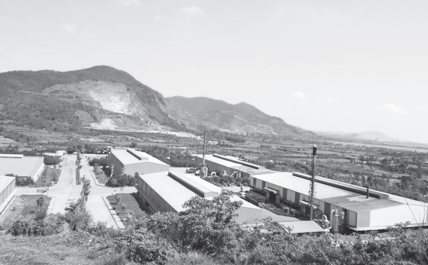
Nhà máy xử lý rác thải sinh hoạt và nhà máy xử lý chất thải công nghiệp tại xã Kỳ Tân, huyện Kỳ Anh. Ảnh: PV
