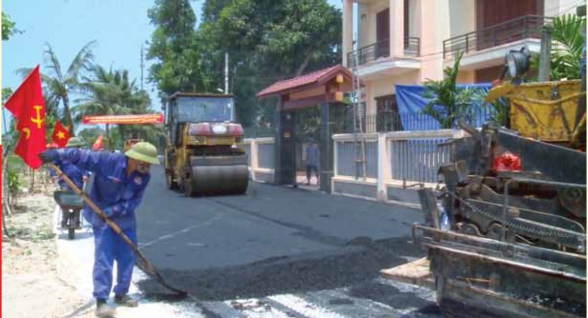
Phong trào tham nhựa nóng đường giao thông tại phường Thạch Linh - thành phố Hà Tĩnh.
