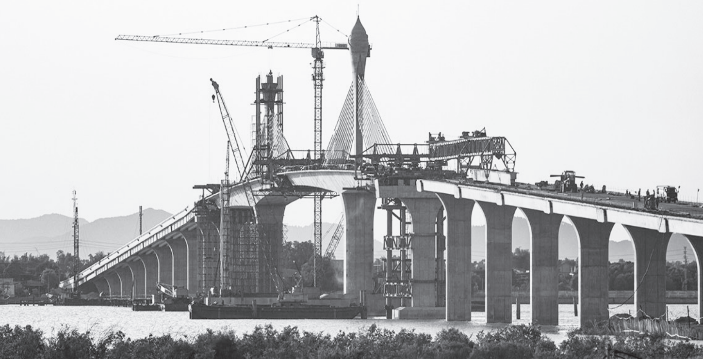
Các nhà thầu đang gấp rút thi công để phần đầu thông xe cầu Cửa Hội. Ảnh: Đặng Thiện Chân
